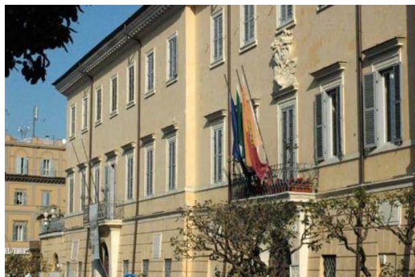
Facciata Palazzo Marconi a Frascati
