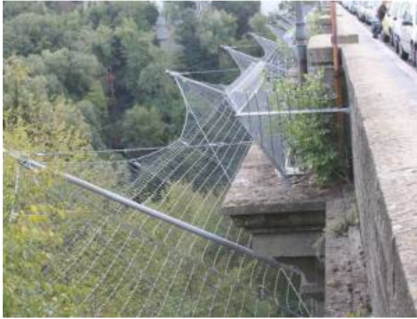
Ponte di Ariccia
