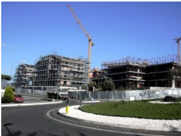
Cantiere Via S. Croce 7 novembre 2013
