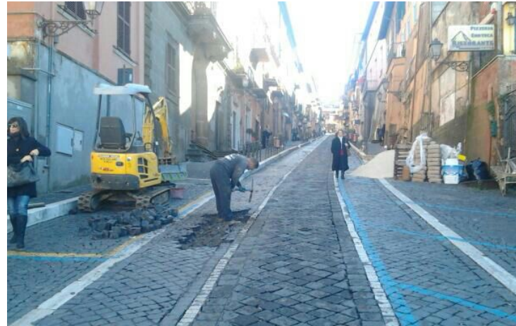
Lavori Corso Costituente a Rocca di Papa
