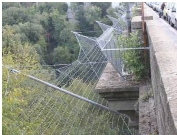
Ponte di Ariccia
