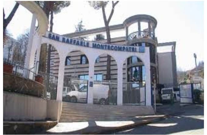
L'ingresso del nosocomio del comune di Monte Compatri ai Castelli Romani
