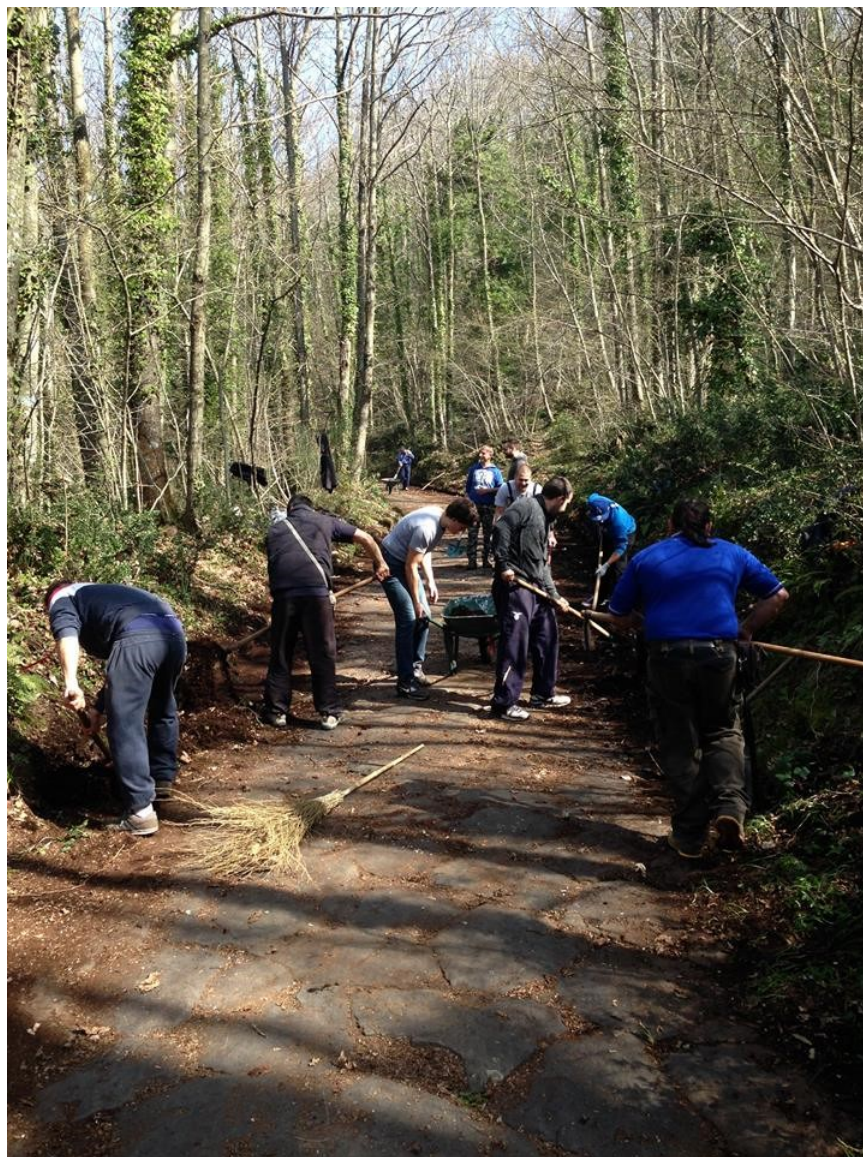
Lavori lungo la via sacra
