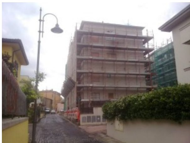
Lavori sugli alloggi comunali a Lariano
