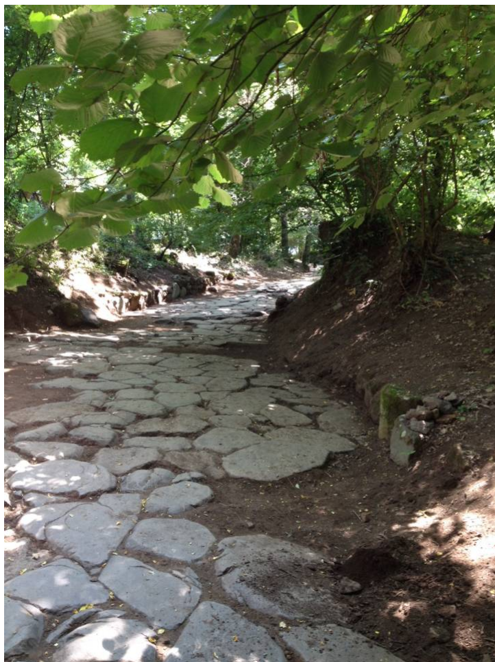
A Tuscolo terminati i lavori a via dei Sepolcri
