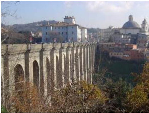
Il ponte di Ariccia collega la città dei Castelli Romani con la vicina Genzano di Roma
