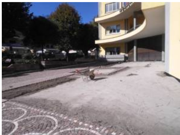
Lavori di ripavimentazione nel piazzale del Municipio di Lariano
