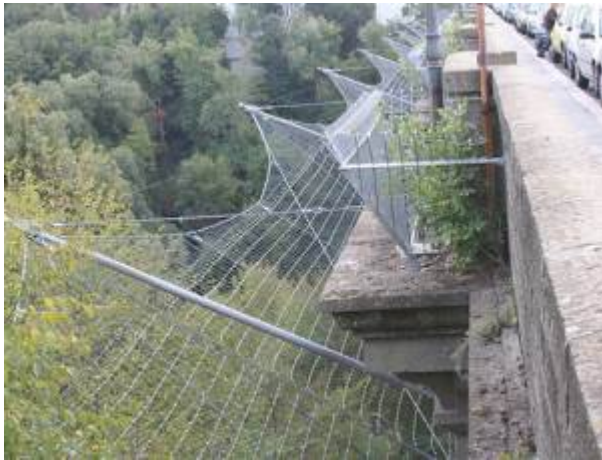
Ponte di Ariccia
