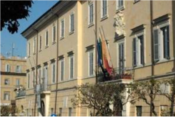
Facciata Palazzo Marconi a Frascati
