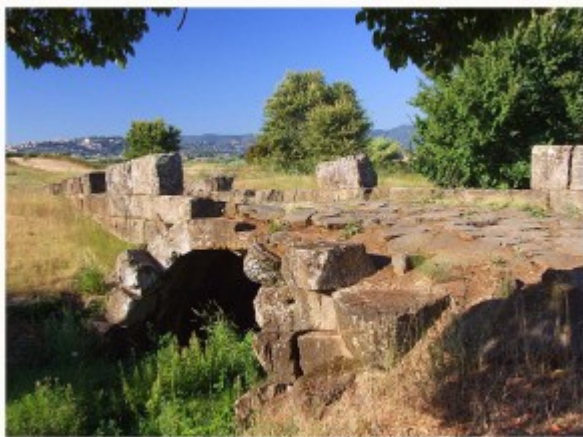
Lanuvio Ponte Loreto
