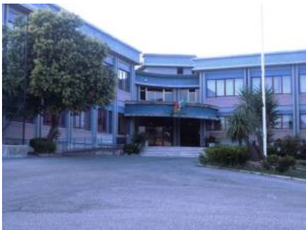
Scuola Media Achille Campanile di Lariano
