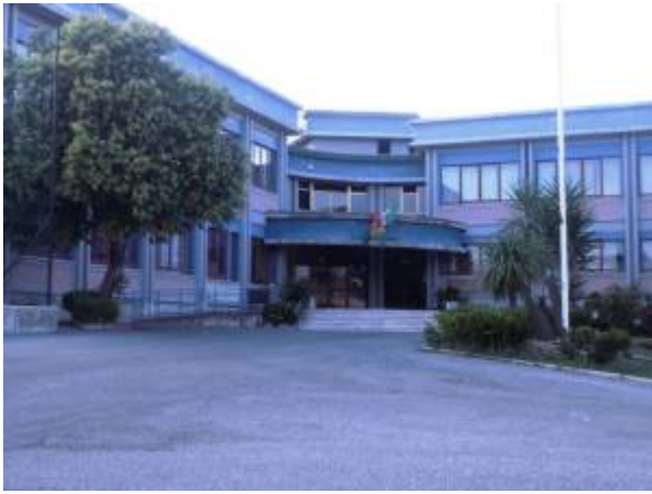
Scuola Media Achille Campanile di Lariano
