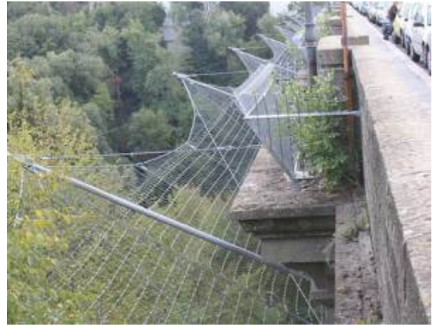
Ponte di Ariccia
