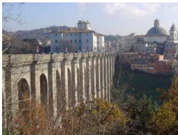
Il ponte di Ariccia collega la città dei Castelli Romani con la vicina Genzano di Roma
