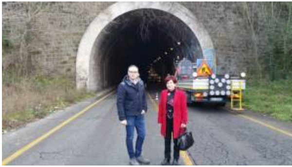
Lavori di ripristino illuminazione alla galleria lungo il Lago Albano
