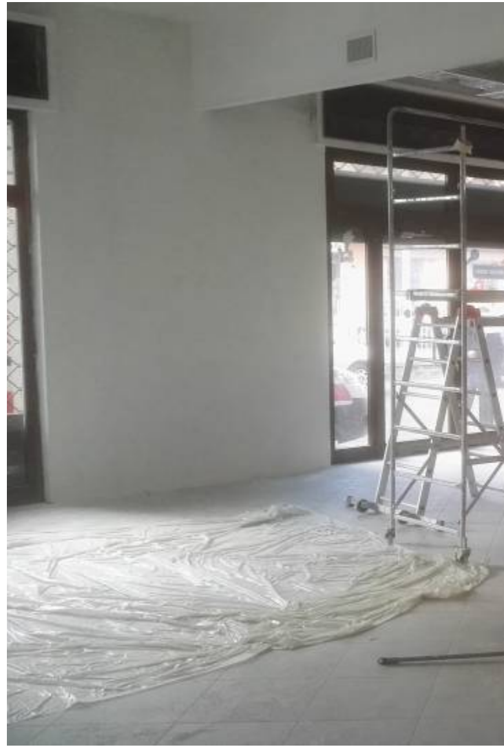
Lavori farmacia Vermicino
