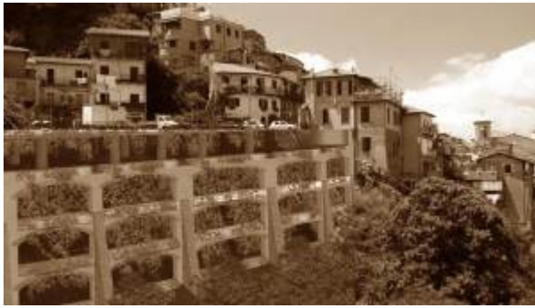
Lavori per parcheggio multipiano in piazza Valeriano Gatta a Rocca di Papa
