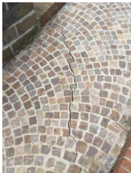
Cantiere scuola elementare Marcello Serra a Castel Gandolfo
