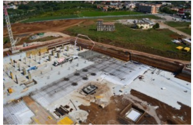
Cantiere lavori per Ospedale dei Castelli Romani
