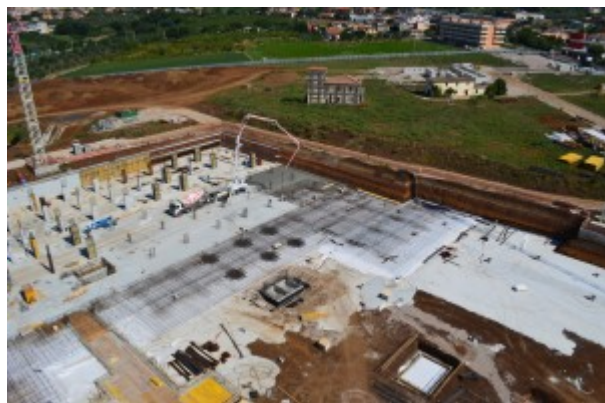
Cantiere lavori per Ospedale dei Castelli Romani
