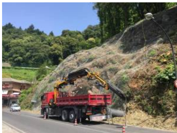
Lavori a Via Nemorense
