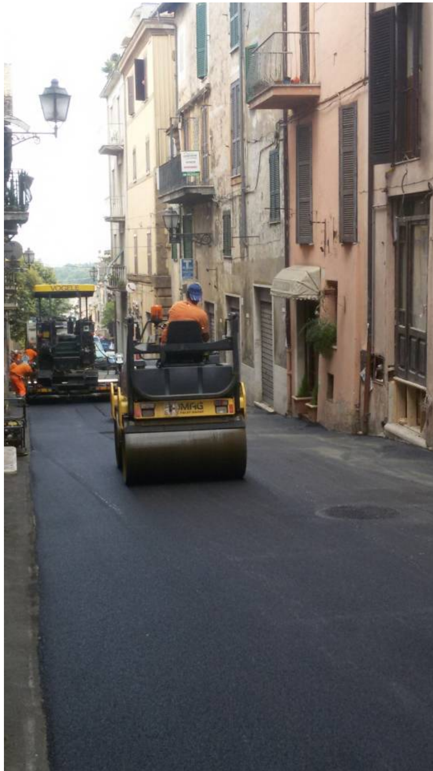
Zagarolo, si sono conclusi i lavori Acea riguardanti la fognatura in Via Calandrelli
