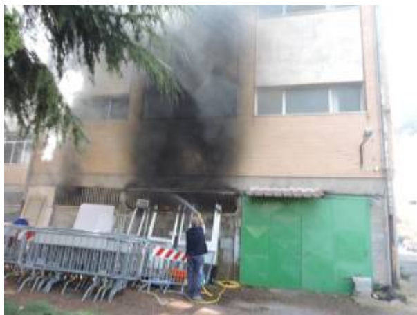
Incendio scuola Marchesi di Genzano (Foto di Luciano Sciorba – Il Messaggero)
