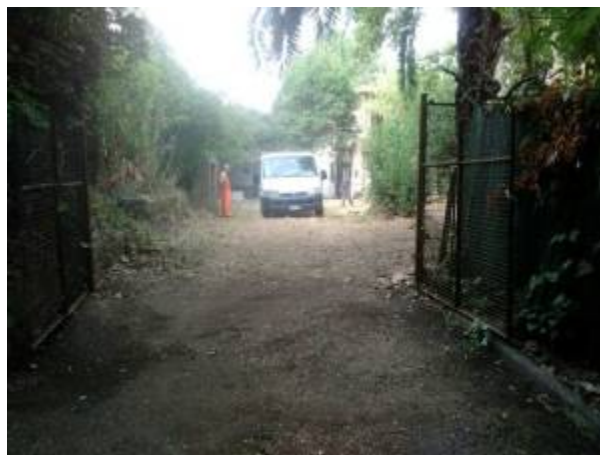
Bonifica nella Casa dell'Intercultura a Frascati
