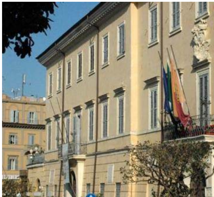
Facciata Palazzo Marconi a Frascati
