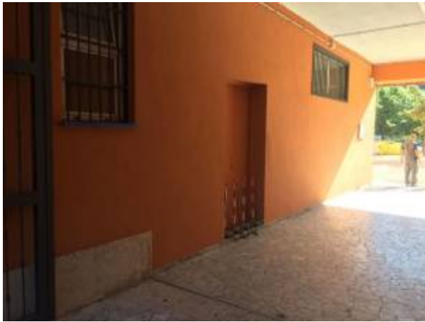
Frascati, muro di Villa Sciarra
