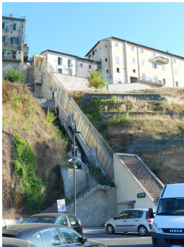
Ascensore Monte Compatri
