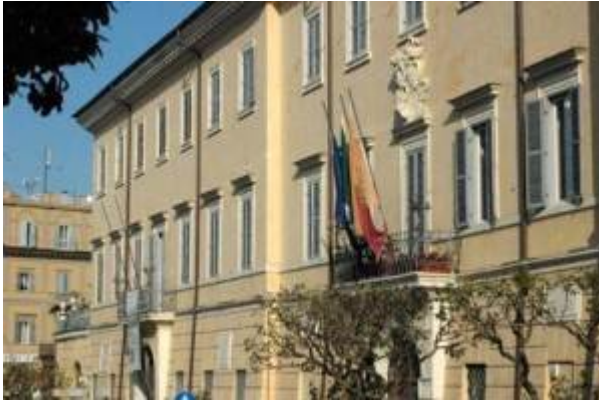
Facciata Palazzo Marconi a Frascati
