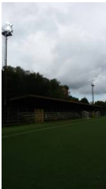
Ripristinati i punti luce delle torri faro del complesso sportivo “Elio Mastrangeli” a Zagarolo
