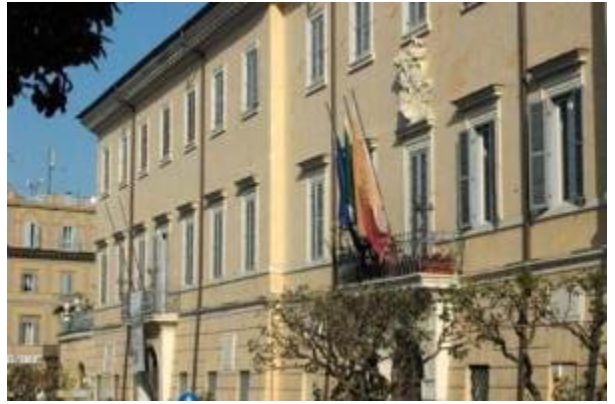
Palazzo Marconi, l'edificio che ospita il Comune di Frascati e alcuni suoi uffici
