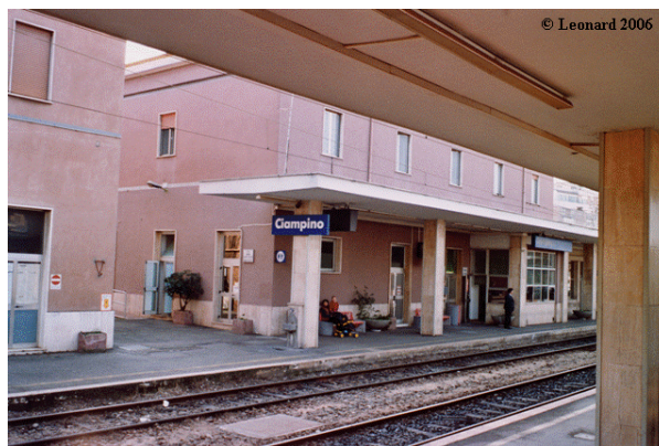
Ciampino stazione ferroviaria
