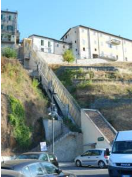
Ascensore Monte Compatri
