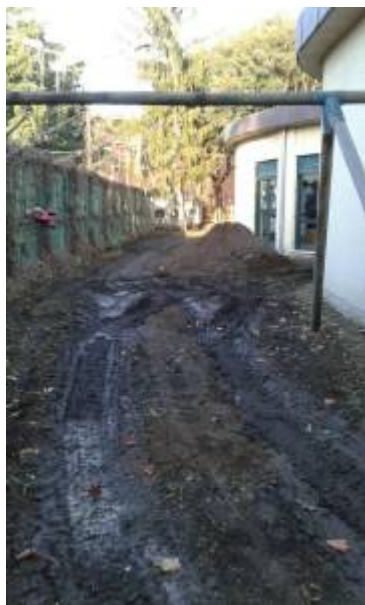
Lavori asilo nido San Carlino Genzano
