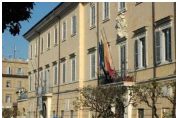
Facciata Palazzo Marconi a Frascati
