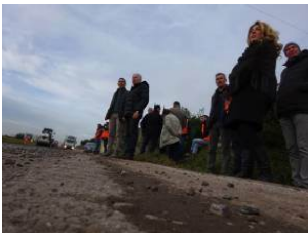
Sopralluogo ai lavori sulla Laurentina del vicesindaco metropolitano Fucci
