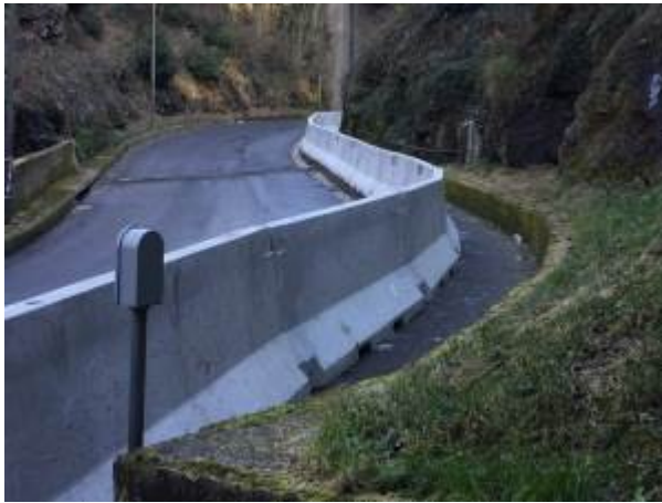
Messa in sicurezza della via Nemorense
