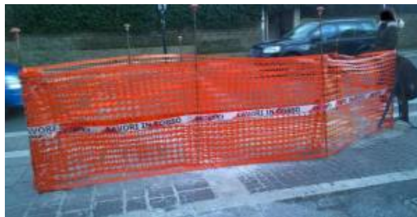
Marciapiede a Pavona di Albano Laziale
