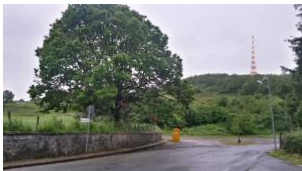
Traliccio antenna Monte Compatri
