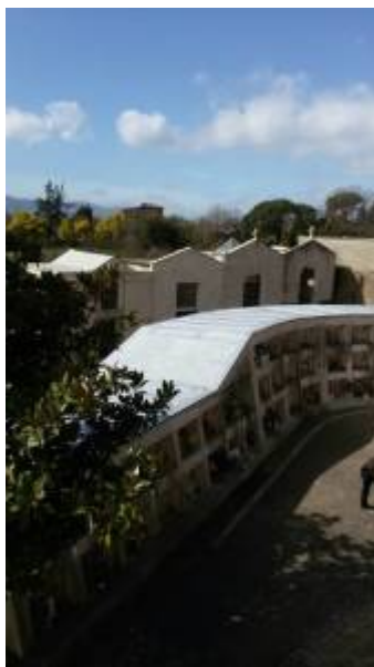
Manutenzione al cimitero di Zagarolo
