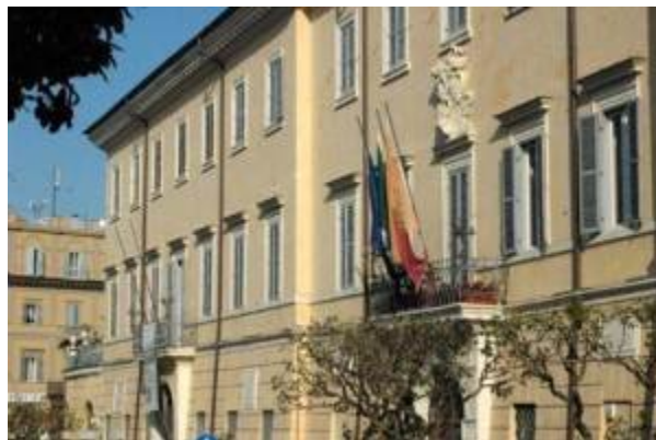
Facciata Palazzo Marconi a Frascati
