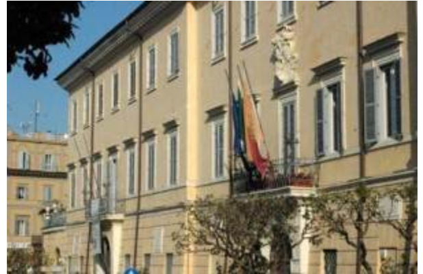
Facciata Palazzo Marconi a Frascati
