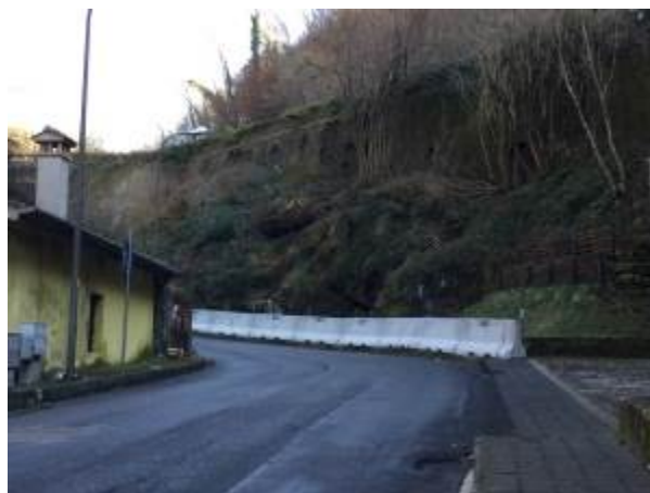
Messa in sicurezza della via Nemorense
