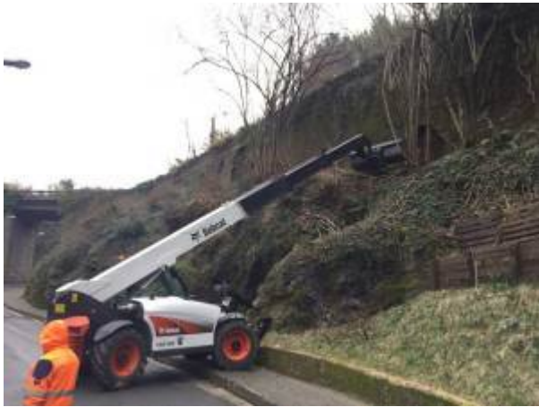
Messa in sicurezza di via Nemorense
