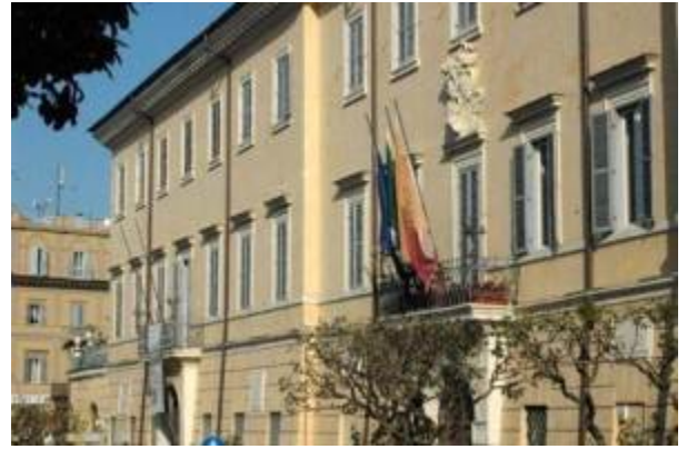
Palazzo Marconi, l'edificio che ospita il Comune di Frascati e alcuni suoi uffici
