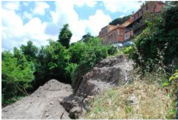
Scesi di sbancamento dove è stato abbattuto il Pino centenario per lasciare posto a nuova palazzina
