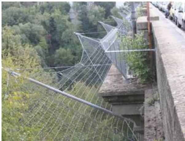
Ponte di Ariccia
